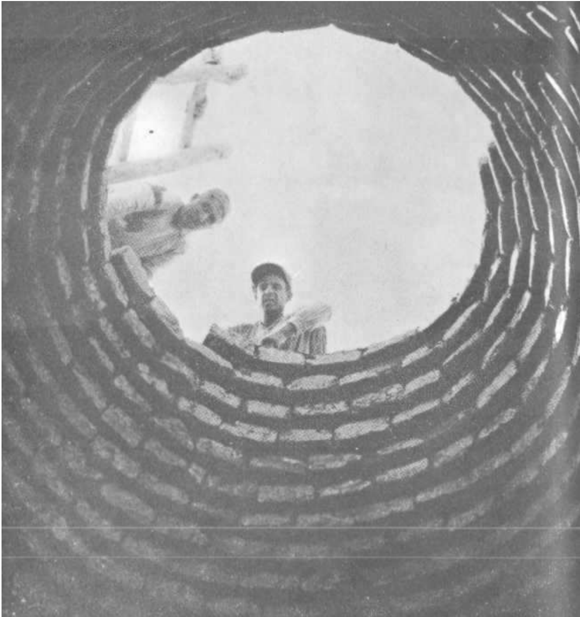
Chagar Bazar — Interior da cúpula durante a construção
