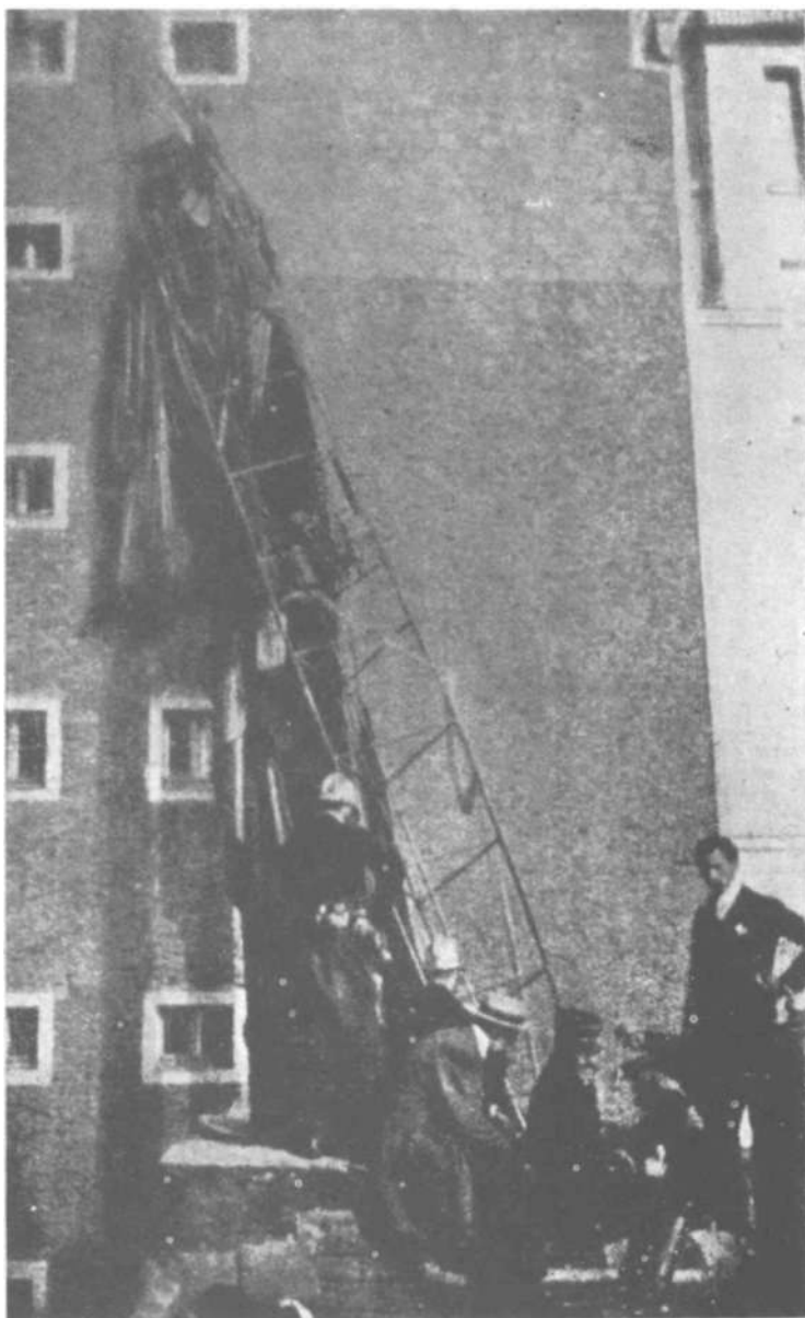
Estado em que ficou o "Nº 5", após cair sobre o Trocadero, em 8 de agosto de 1901
